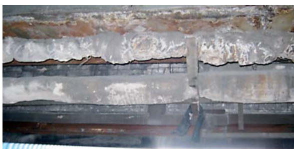
工場入口のすぐ頭上にアスベストが使用されていた。
