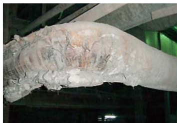
頭上のパイプ(アスベスト剥離部分)。
