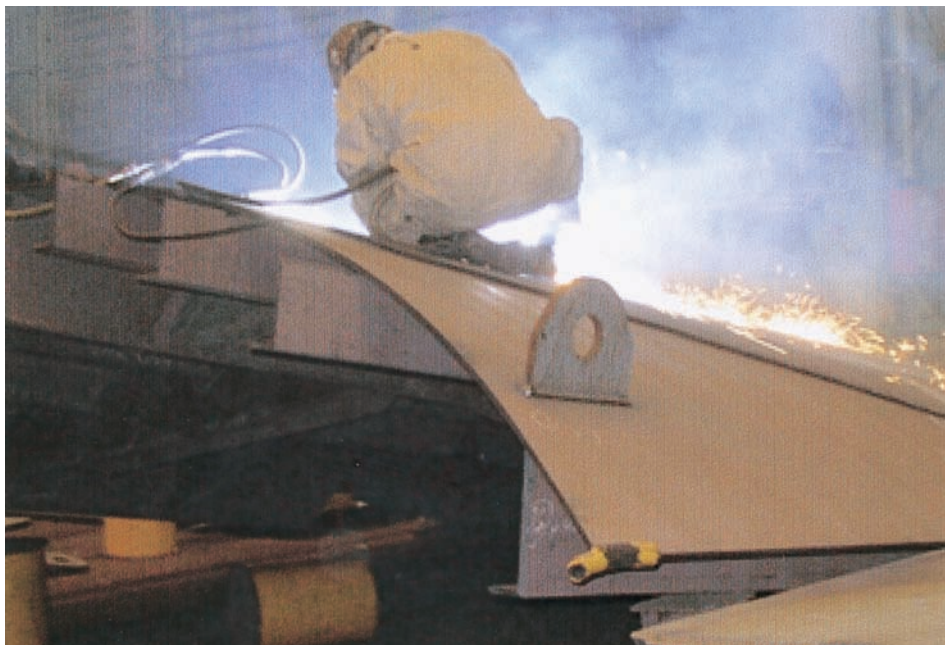
ガス溶接作業 (造船所)
