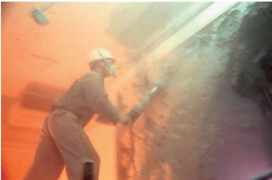
石綿吹付け作業
