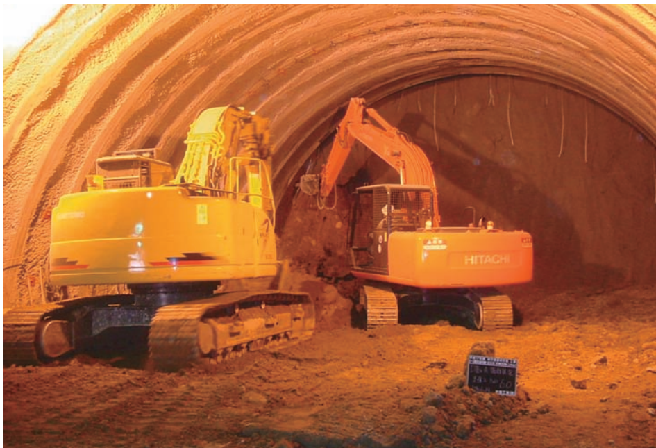
掘進作業現場（佐藤工業提供）
