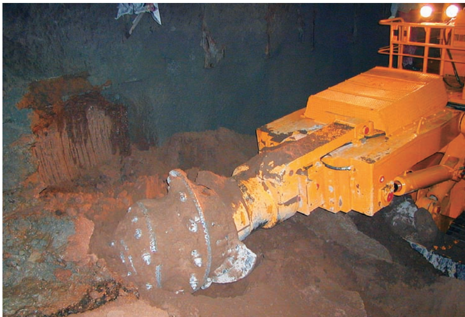
隧道作業現場
