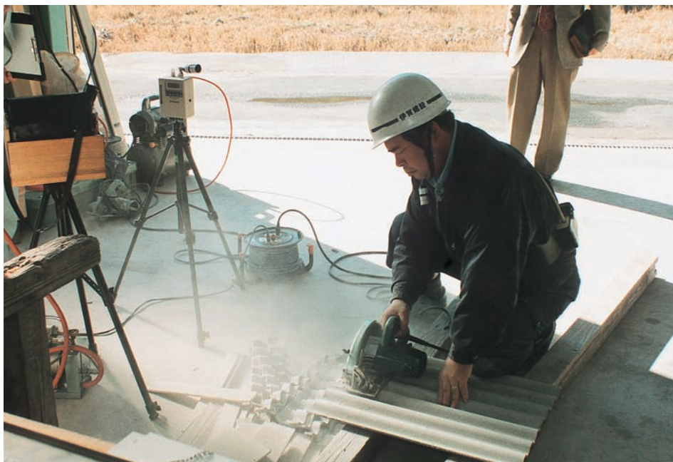
石綿入り波形スレート切断作業
