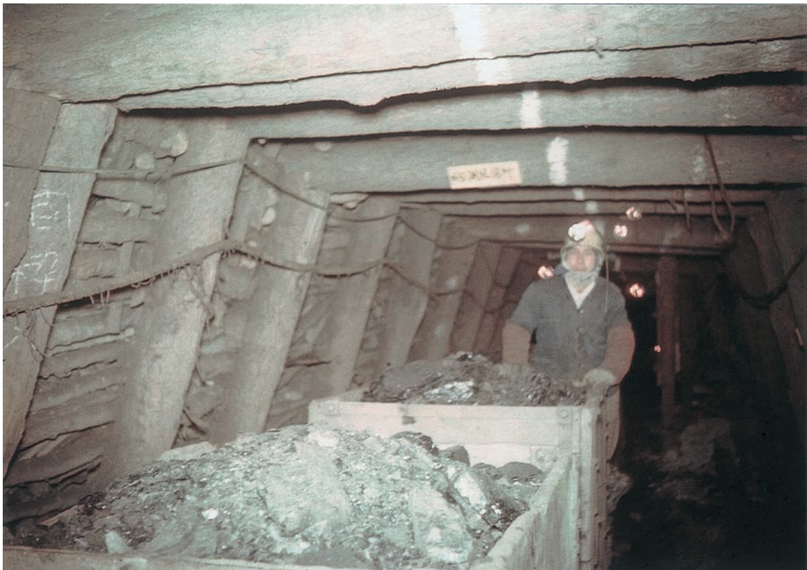
坑道内運搬作業
